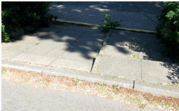
Zu- und Übergänge an den Parkplätzen mit fehlender Bordsteinabsenkung und Schwellen im Gehverlauf
