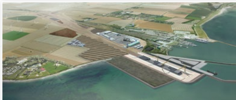
Beispielhafte Darstellung der Baustelle auf Fehmarn
