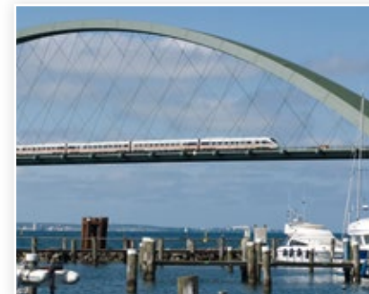
Fehmarnsundbrücke, Quelle: DB/Günter Jazbec
